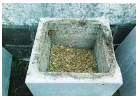
Mini-silo de Betão
