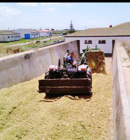
Figura 2: Silo trincheira da AJAMCJA a ser carregado.
